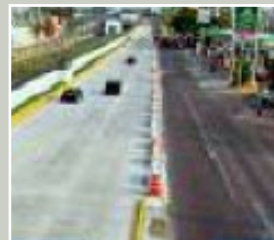
Temperatura promedio, Concreto: 33°C (92°F)
